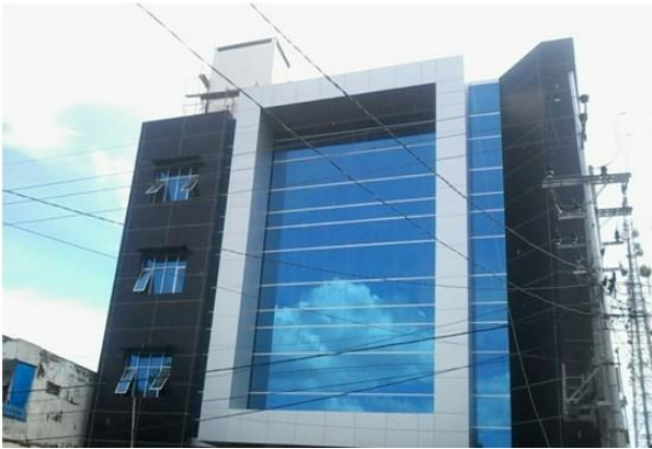
MAINTENANCE AC DI MALL LEUBERRE SUMENEP MADURA
