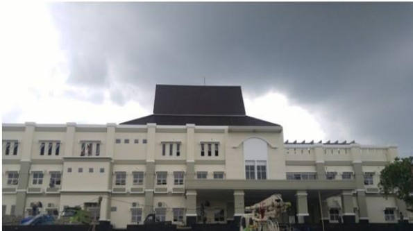
MAINTENANCE AC DI GEDUNG KANTOR TIK DAN BMN SURABAYA
