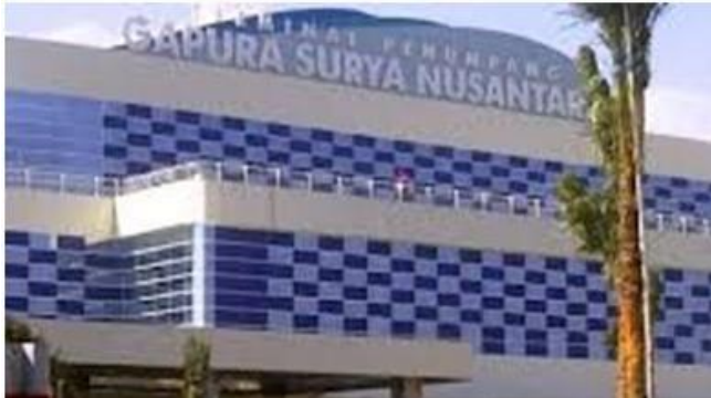
PENGADAAN DAN INSTALASI UNIT AC DI GAPURA SURYA NUSANTARA PT. PELINDO III
