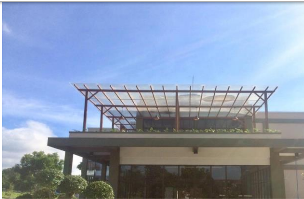
PENGADAAN DAN INSTALASI AC DI BLK LOMBOK TIMUR, NTT
