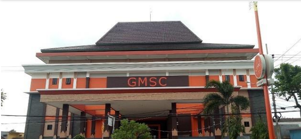
MAINTENANCE AC DI GEDUNG GMSC MOJOKERTO
