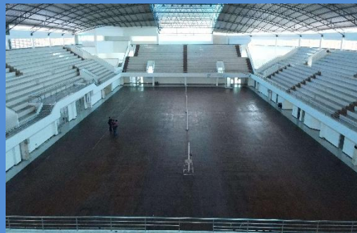
PENGADAAN DAN INSTALASI UNIT AC DI GOR KEN AROK
