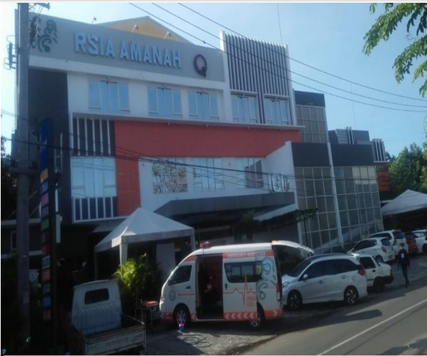
MAINTENANCE AC DI GEDUNG RSIA AMANAH PROBOLINGGO
