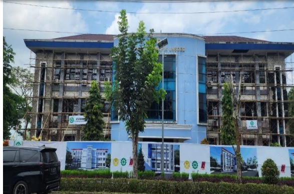
PENGADAAN DAN INSTALASI UNIT AC DI GEDUNG F. TEKNIK UNSOED
