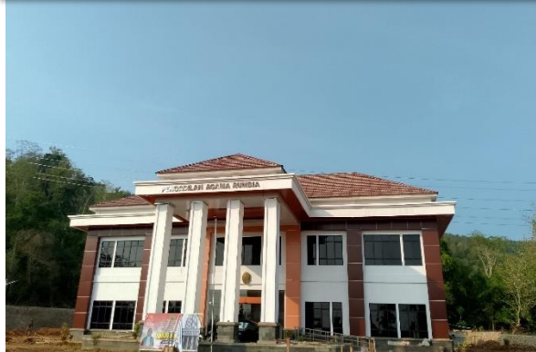
PENGADAAN DAN INSTALASI UNIT AC DI PENGADILAN AGAMA RUMBIA
