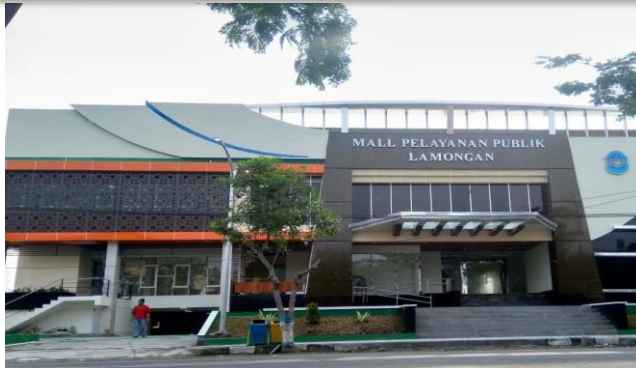
PENGADAAN DAN INSTALASI UNIT AC DI MALL PELAYANAN PUBLIK LAMONGAN
