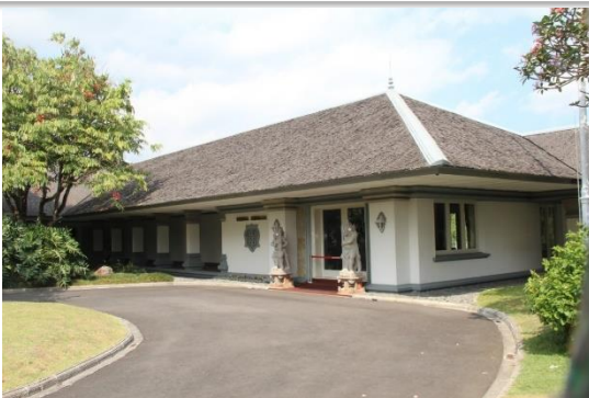
PENGADAAN DAN INSTALASI UNIT AC DI ISTANA TAMPAK SIRING
