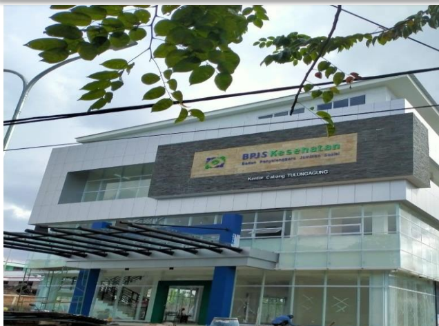
PENGADAAN DAN INSTALASI UNIT AC DI BPJS KESEHATAN TULUNGAGUNG
