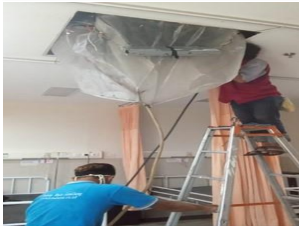
MAINTENANCE AC DI GEDUNG RSIA AMANAH PROBOLINGGO
